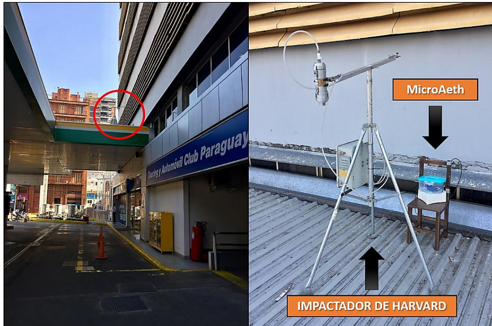
Figura 3: Fotografías de la instalación de los equipos de monitoreo en “Touring y Automóvil Club Paraguay”. Izquierda: Fotografía en perspectiva de la ubicación de los equipos de monitoreo sobre el techo de la bencinera PETROBRAS. Derecha: Fotografía de los equipos monitoreo. Fuente: Elaboración propia.
