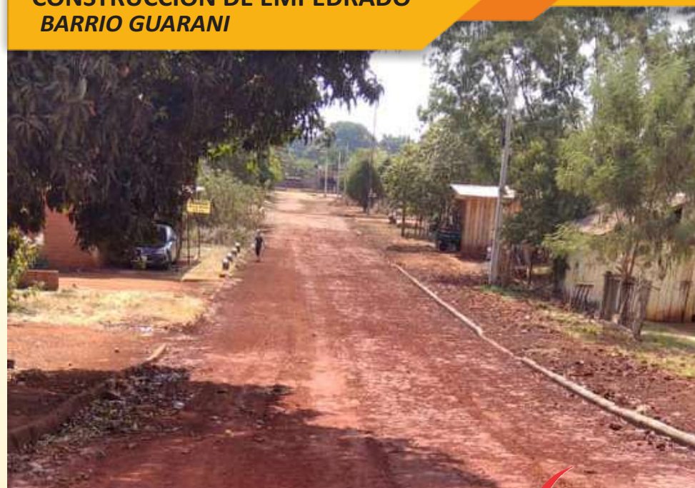
CANALIZACIÓN DE PIEDRA BRUTA COLOCADA CON TAPA DE Hº Aº
